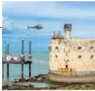
p. 30. Bain de jouvence pour Fort Boyard avec des travaux de sauvegarde commencés en juillet 2025.
