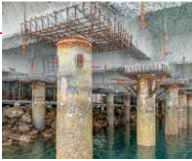
p. 20. La rénovation/ restructuration des ouvrages est une réalité économique. Et parfois plus logique qu'une démolition/reconstruction.
