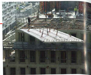
p. 16. La préfabrication offre bien des avantages : lutte contre la pénibilité, réponse viable vis-à-vis des aléas climatiques, décarbonation....
