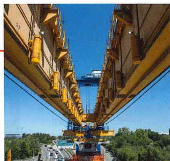
p. 26 – Impressionnante, la poutre de lancement du métro de Toulouse se développe sur 110 m de long et affiche un poids de 600 t.
