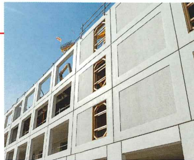
p. 70 – Venue d'Allemagne, la technique du prémur est, à présent, bien implantée en France...
